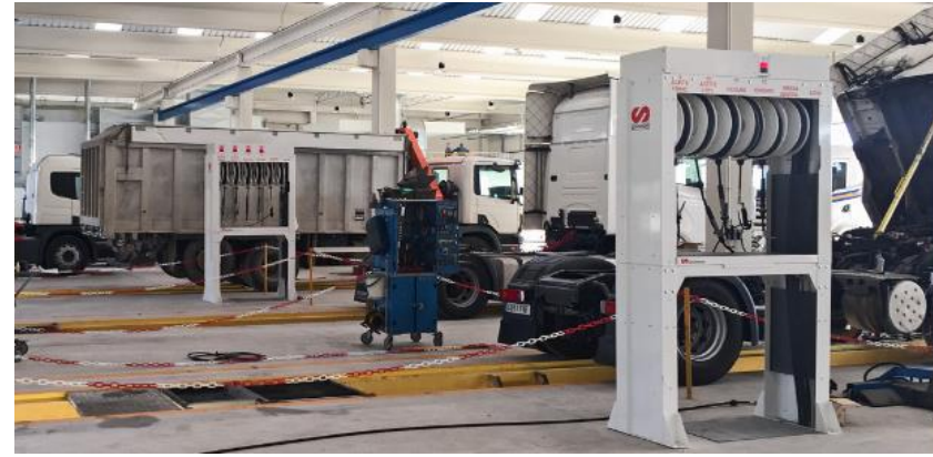
Оборудование для обслуживания парка техники
